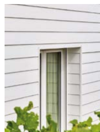
Pose à recouvrement
